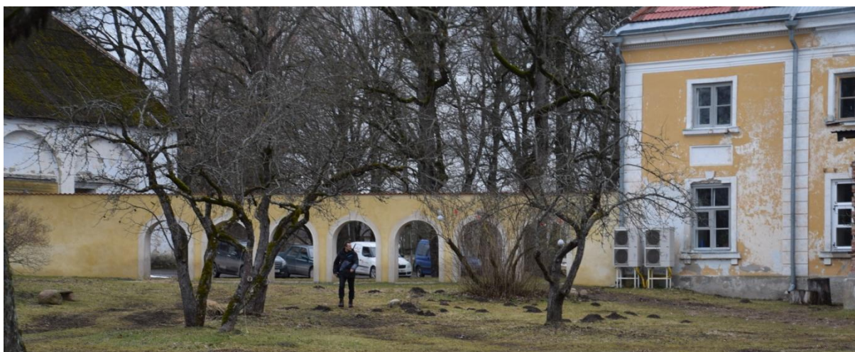
Fotod 17-18. Esi- ja tagaväljakut eraldav kaaristu; ülal restaureerimata 2009. a, all restaureerituna 2015 (foto Heiki Kalberg).
